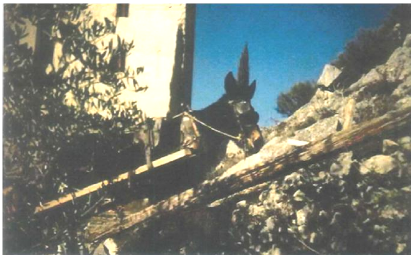
Mulet utilisé pour le chantier de réfection de l'église Saint Martin-Saint Sébastien 1977-1978
